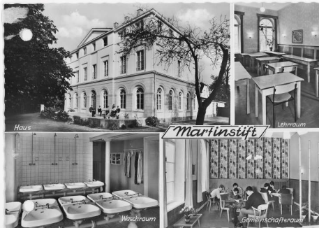
Quelle: AEKR 85L 108 (Diakonisches Werk - Bildarchiv), Nr. 157/3 Bildnachweis: Verlag Bilddokumentation Krebs, Krefeld-Bockum Gebäude innen und außen (Postkartenmotiv) Martinstift, Moers
